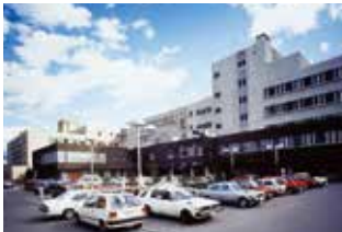
1975(昭和50)年 完成した新病院
