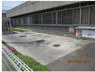
地下貯蔵タンク (5万ℓ)
